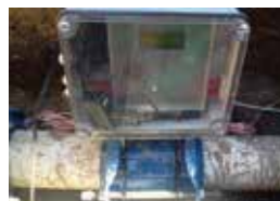
Instalación del equipo en una caja protectora sellada la cual lo protege de la lluvia y el Sol. Instalación Día 2 de Octubre de 2012.
